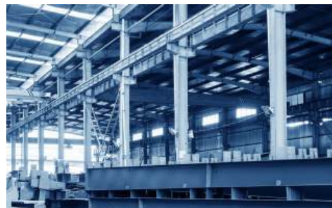
Nhà xưởng, Kho hàng, nhà máy
